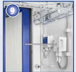
Sistema versátil de sondas para medición de diferencias de temperatura y presión que garantiza su control en función de la demanda real.
