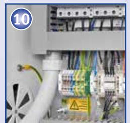
Controles modulares y ampliables para uso con PC industriales que pueden comunicarse con prácticamente todos los sistemas de gestión del edificio a través de BACnet y Modbus. Componentes electrónicos alojados en un armario de distribución ventilado y de fácil acceso.
