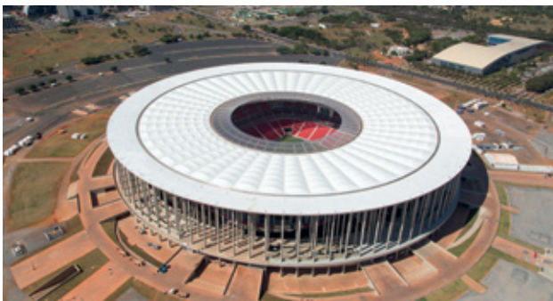
Estádio Nacional, Brasília: TROX-ventilatietechnologie in alle nieuw gebouwde WK-stadions in Brazilië
