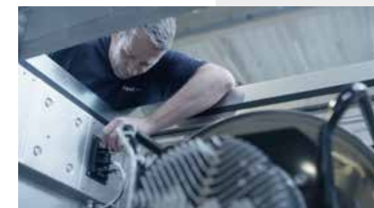
Raccordement du ventilateur
