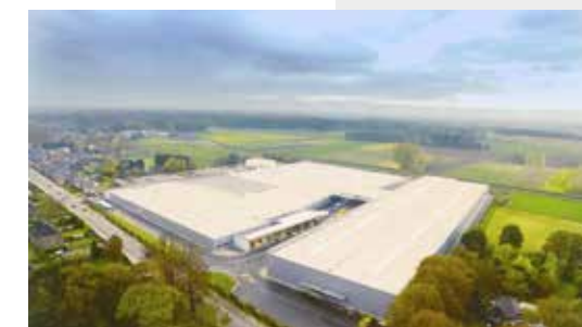
Hall de production X-CUBE à Anholt
