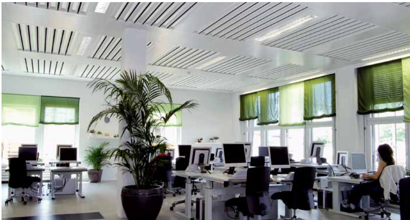
La Poste Suisse, Coire, Suisse Plafond froid
