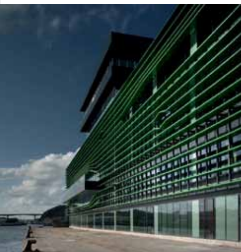
Edificio IDOM, Bilbao, Espagne
