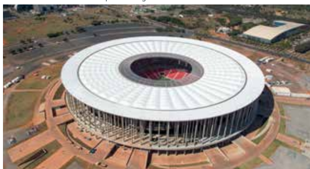
Estádio Nacional, Brasília Ventilation et climatisation TROX dans tous les nouveaux stades de la Coupe du monde au Brésil
