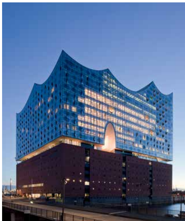
Elbphilharmonie Hamburg : Ventilation TROX et climatisation dans toutes les salles de concert
