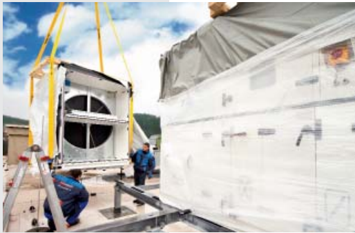
Uitlevering en montage van een weersbestendige X-CUBE
