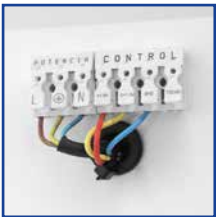
Détail boîte à bornes sur les unités Fancoil
