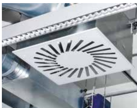
Diffuseurs à jet hélicoïdal - fonctionnement silencieux grâce au soufflage optimisé.
