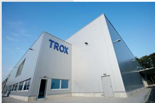
Usine de production TROX à Anholt (Allemagne)
