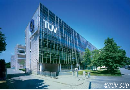
Les centrales de traitement de l'air TROX sont contrôlées par l'organisme de contrôle indépendant TÜV SÜD.
