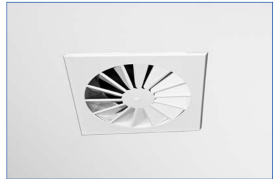
Montage dans des plafonds fermés
