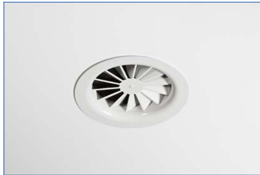
Montage dans des plafonds fermés
