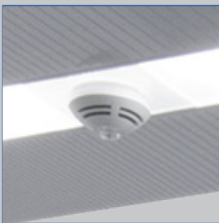
Détecteur de fumée
