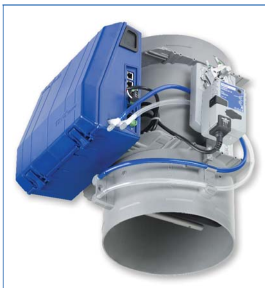
Unité terminale VAV, version TVLK, avec déflecteur et manchette de raccordement circulaire
