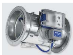
Station de mesure du débit d'air, version VMR/.../B10
