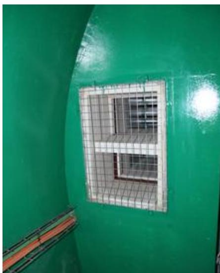
**Cegelec a choisi d'installer les Clapets coupe-feu TROX FKT HCM 120 entre les tunnels et inter-tubes afin d'isoler la partie tunnel de la zone d'évacuation.**
