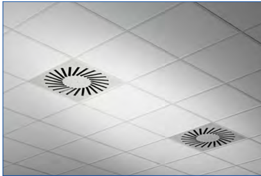
Inbouw in T-profiel systeemplafond, plaatsing in rijen
