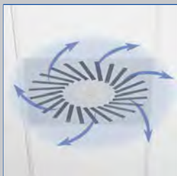
Wervelvormige, horizontale uitblaas
