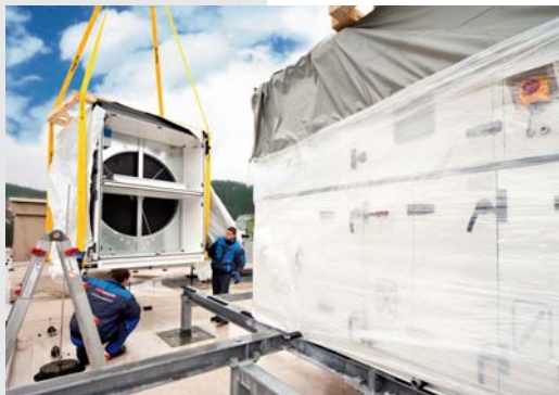
Uitlevering en montage van een weersbestendige X-CUBE
