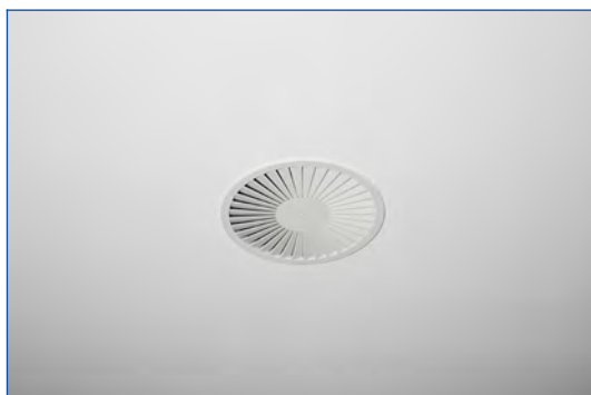
Inbouw in gesloten plafond
