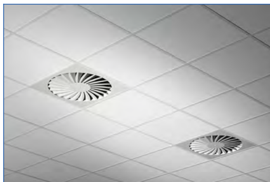
Inbouw in T-profiel systeemplafond, plaatsing in rijen
